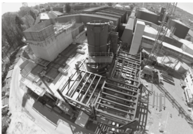
Klärschlammverwertungsanlage im Bau, Stand April 2014. (Bild: ERZ)
