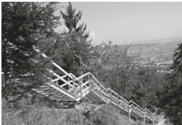
Der sanierte, auf dem Fels verankerte Föhrenweg verläuft neu entlang der Geländekante. (Bild: GSZ)
