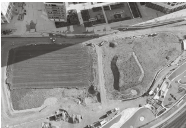
Der Park Pfingstweid nimmt Formen an. (Bild: GSZ)
