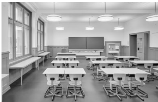
Gesamtinstandsetzung Schulanlage Gubel A – Klassenzimmer. (Bild: Roger Frei)
